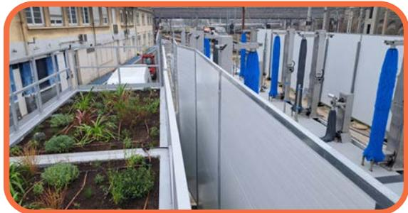
Le toit du local technique de cette machine à laver joue aussi sa partie : il est végétalisé, pour atténuer l'effet « îlot de chaleur » autour et limiter à l'intérieur l'utilisation de la climatisation.
